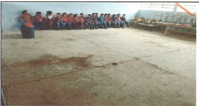
Foto 3: Sustitucion de tortado por piso ceramico (Modulo 2)
