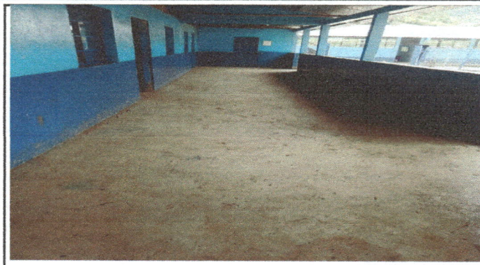
Foto 2: Sustitucion de piso de torta por ceramico ( corredor Modulo 1 )
