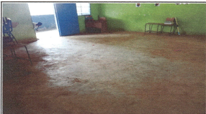
Foto1: Sustitucion de piso de torta por ceramico (Modulo 1)
